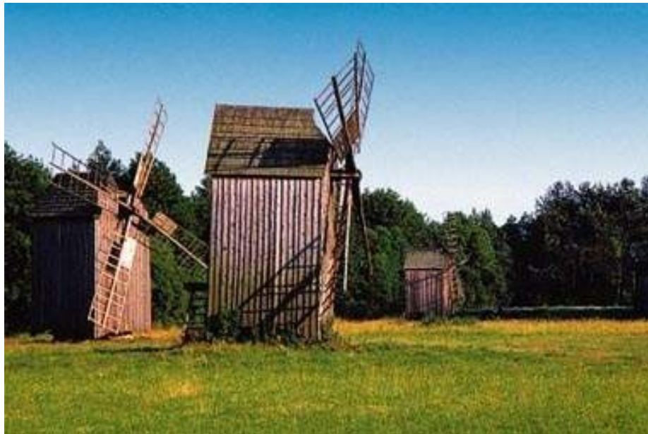
Koźlak z Zarebek Wiatrak - koźlak postawiony w końcu XIX wieku w Woli Domatkowskiej, w 1920 roku przeniesiony do Zarebek. Budynek drewniany, o konstrukcji słupowo - szkieletowej, oszalowany deskami.
